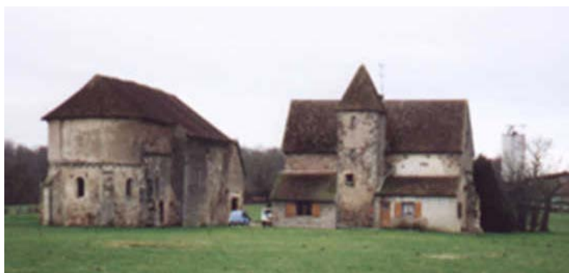
Maison du Temple Le Feuilloux - Image O.S.J
